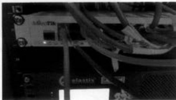
**17:00 pm** Se identificó y conecto los cables del pacht panel B al Swicht microtik
