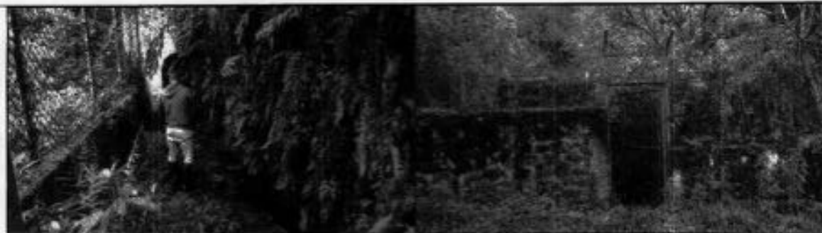
Figura 12.- Captación Galo Vicuña.
