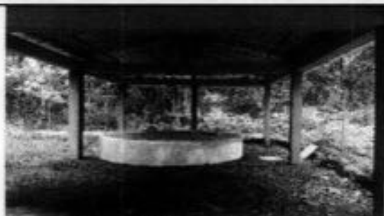
Figura 19.- Tanque Los Ceibos.
