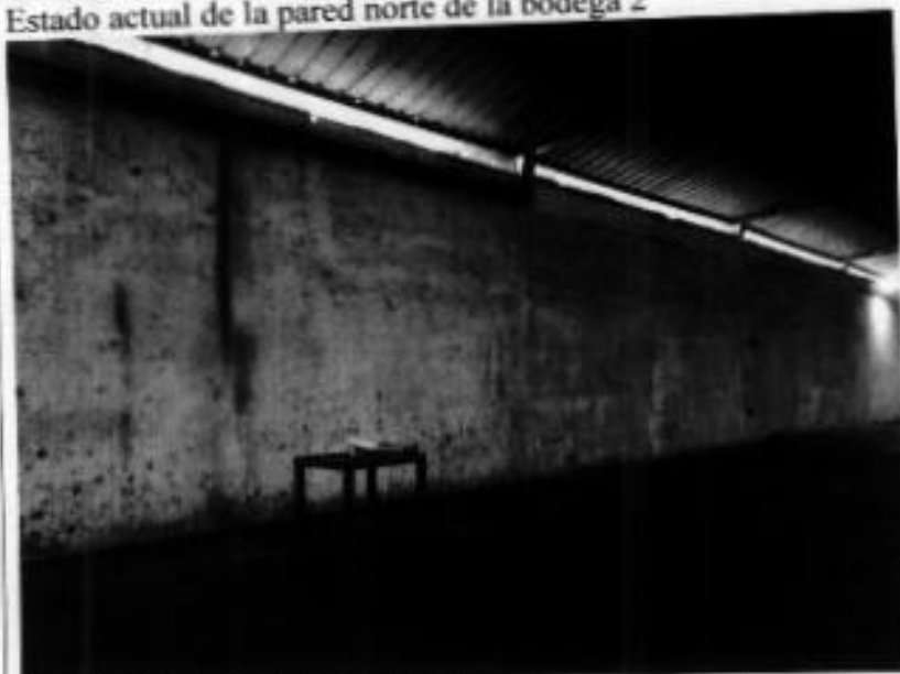
Paredes laterales de la bodega 2
