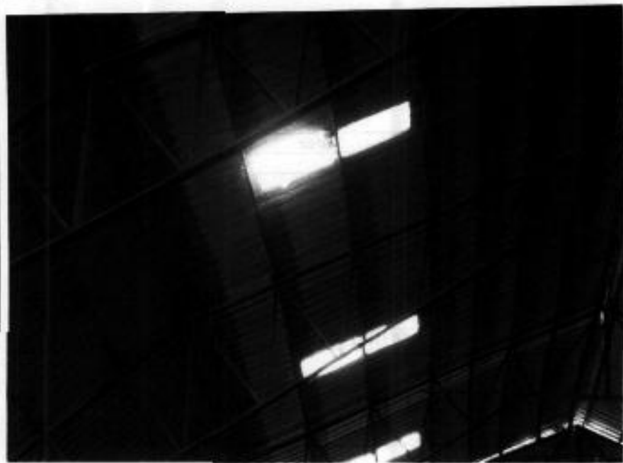
Estado de la cubierta bodega 3
