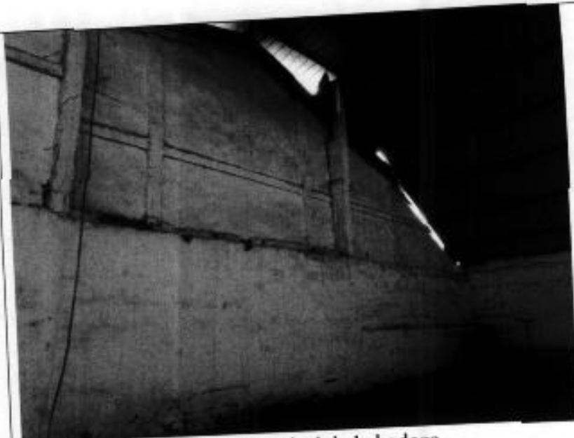
Mampostería y estructura vertical de la bodega
