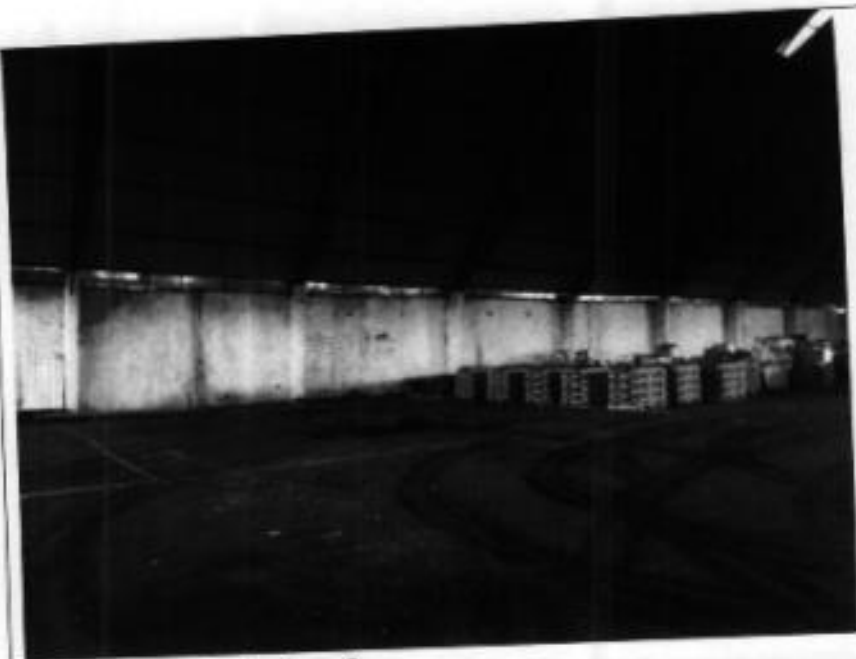
Paredes laterales bodega 3
