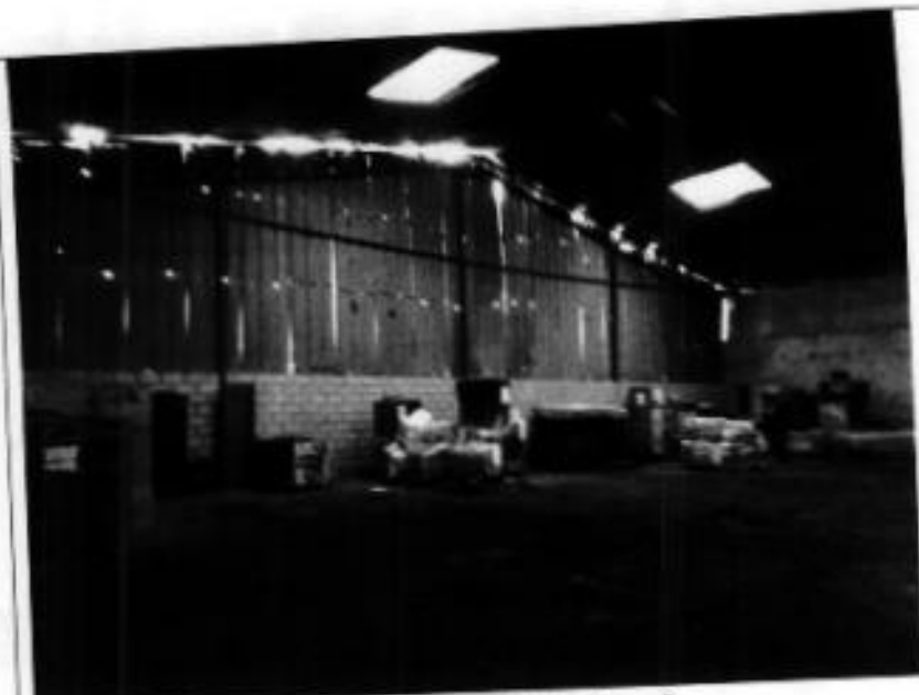
Estado actual de la pared norte de la bodega 2
