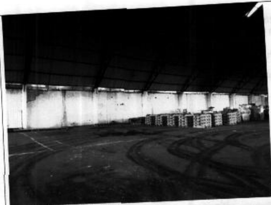
Paredes laterales bodega 3
