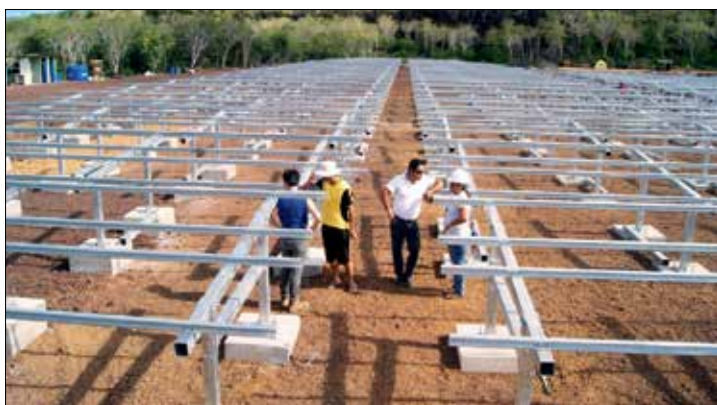
El objetivo es instalar 6.000 placas fotovoltaicas.
