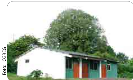
Instalaciones en San Cristóbal.
