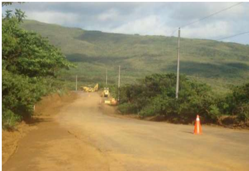
FOTO # 6: CARRETERA PUERTO BAQUERIZO MORENO – EL PROGRESO. OBRAS DE CONSERVACIÓN Y MANTENIMIENTO
