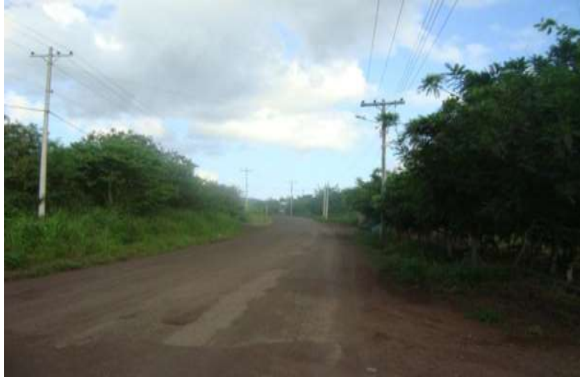
FOTO # 5: CARRETERA PUERTO BAQUERIZO MORENO – EL PROGRESO
